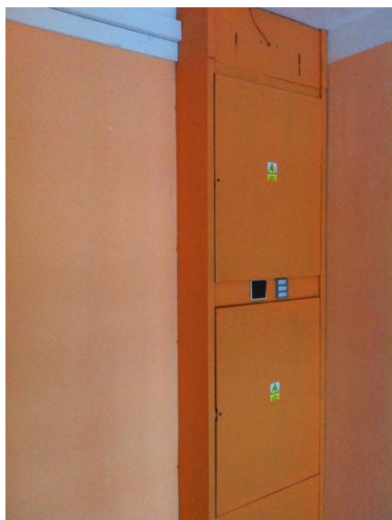
Obr. č. 3: umístění rozvaděče
