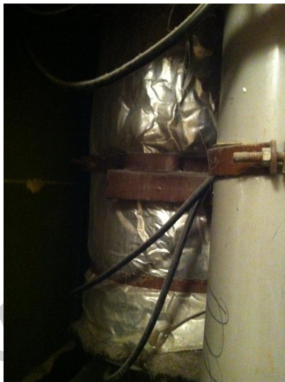
Obr. č. 4: vertikální rozvody vzduchotechniky
